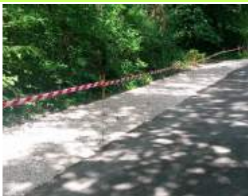
Renforcement du chemin du Taillis
