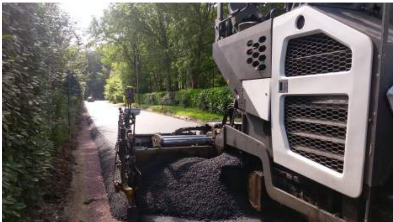
Réfection de la chaussée de la route du Chêne rogneux
