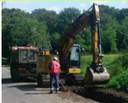
Travaux route de la Petite noue
