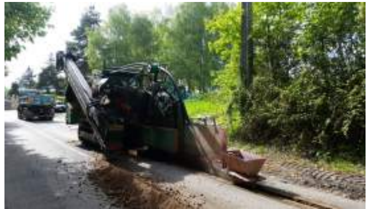
Installation des gaines où passera la fibre optique
